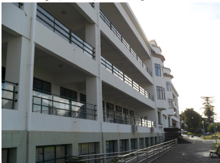
Figura 5 - Sanatório João Almada e as galerias de cura.
