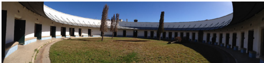
Figura 4 - Vista geral do interior do antigo Pavilhão de Segurança.
